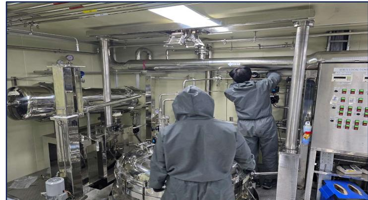
삼양홀딩스 MD공장 [(PGA 중합반응 시스템) , (OXIDATION 시스템)]
